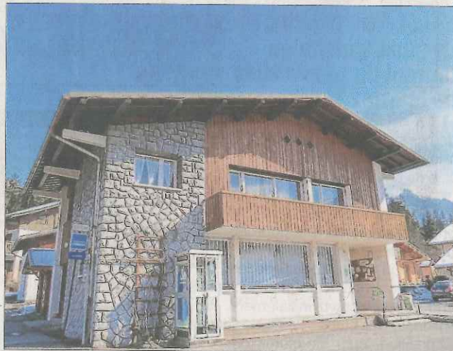
C'est au 1 er étage de l'ancienne poste que le Sivom a installé ses bureaux. Le rez-de-chaussée accueillera cet automne la Mission locale jeunes. Photo Le DL/O.L.
